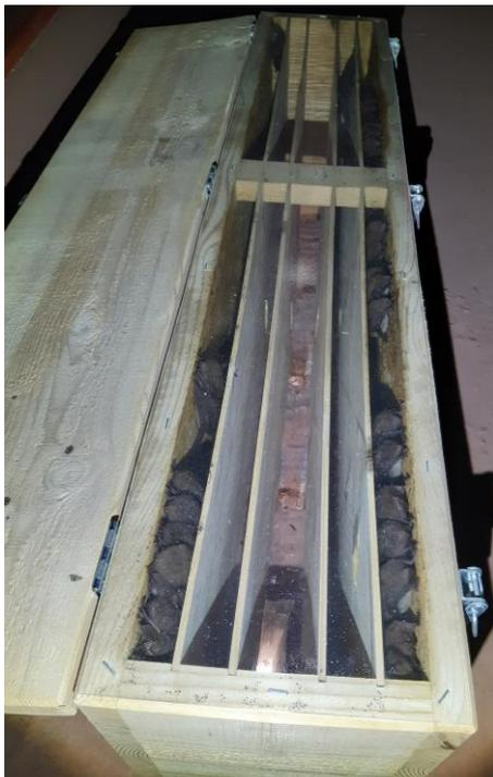
Figure 13 : Un nichoir vu de l'intérieur du pont. Un couvercle amovible permet d'évaluer la fréquentation de chaque nichoir.
