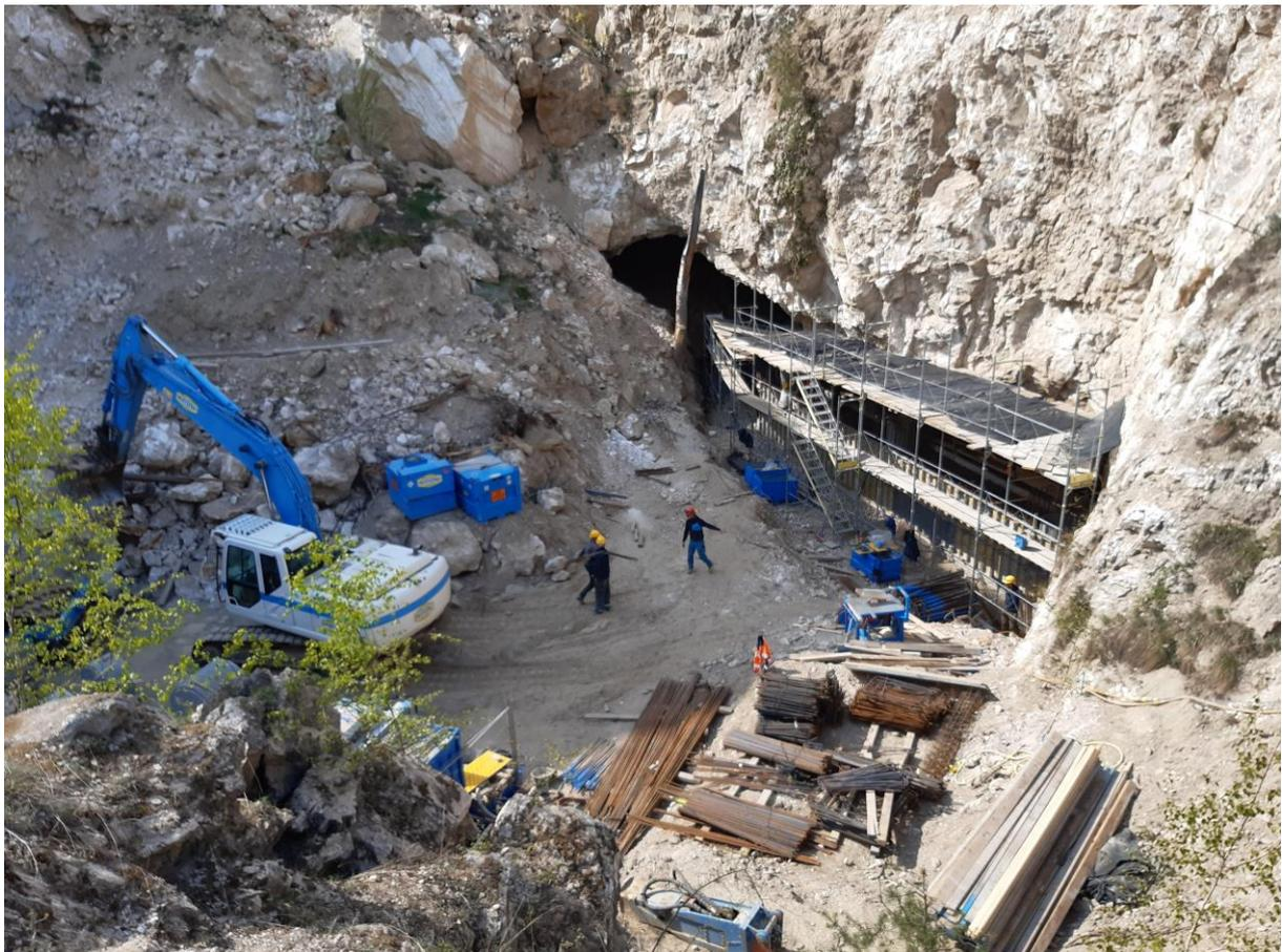
Figure 15 : Construction de la galerie artificielle permettant de maintenir l'accès au réseau souterrain inférieur existant.
