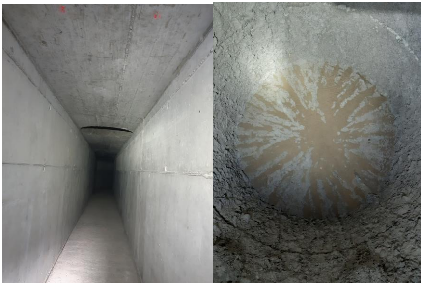
Figure 18 : Galerie artificielle du réseau de galeries du bas, aménagé avec deux cloches thermiques, dont l'intérieur est tapissé de structure permettant aux chauves-souris de s'y accrocher.
