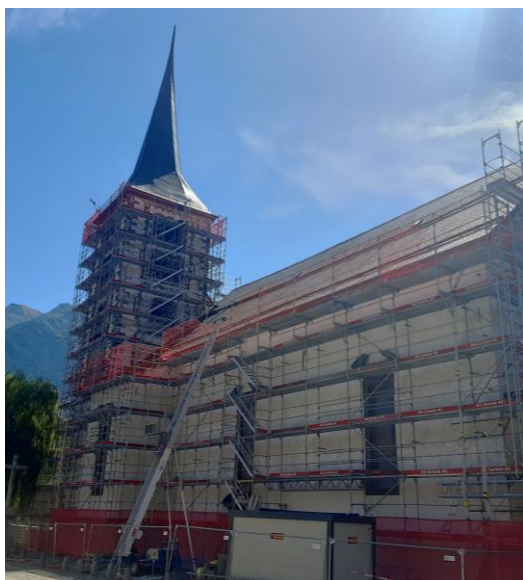
Figure 5 : L'Eglise de Naters, réfection de la façade (2021).
